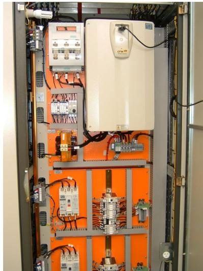
Figura 3.1: Componentes internos de um painel. Fonte: WEG Automação S.A.
